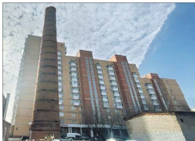
Труба котельной на Совхозной улице
