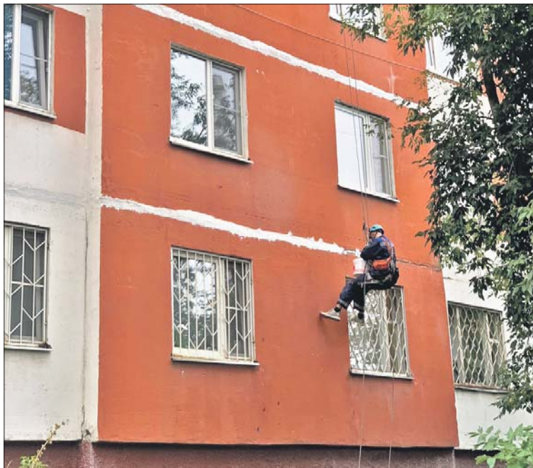
Герметизация межпанельных швов на Самаркандском бульваре, 137а, корпус 4
