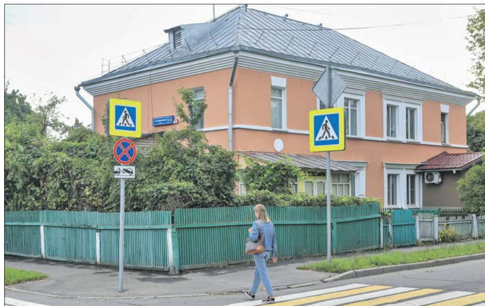
Коттедж на несколько квартир для сотрудников станции аэрации
