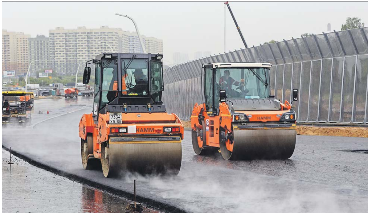
По мосту деловито снуют катки — строители укладывают асфальт
