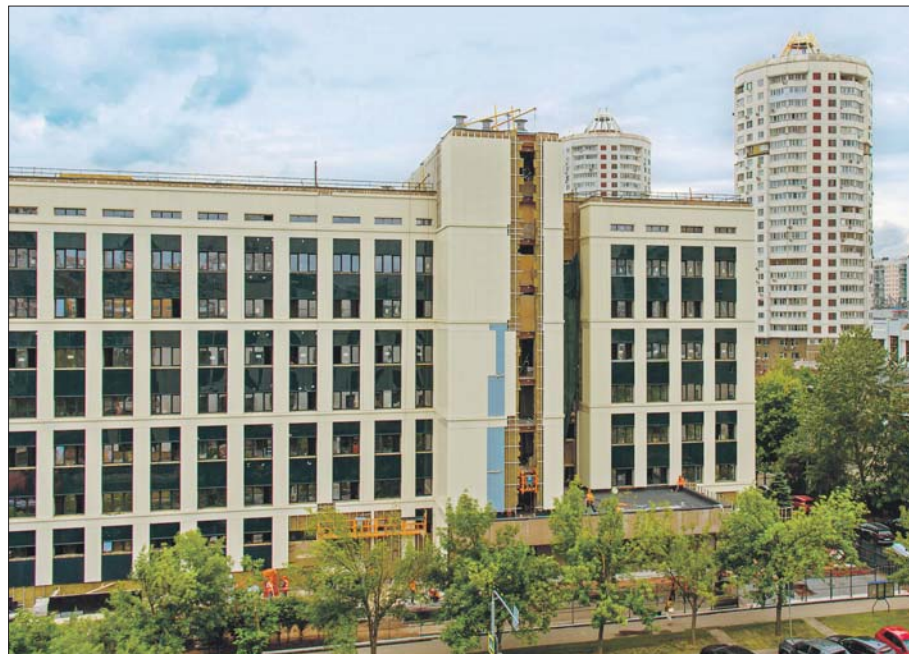
Мэр поручил ускорить реконструкцию поликлиники №36 на Новомарьинской улице
