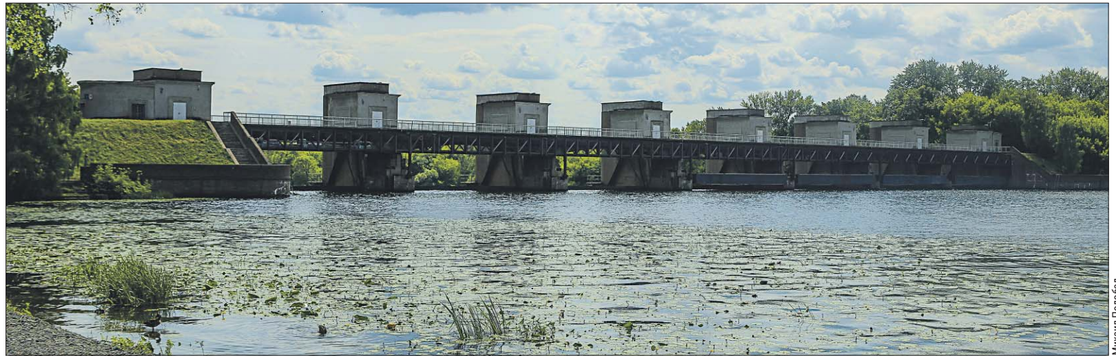
Железобетонная плотина Перервинского гидроузла
