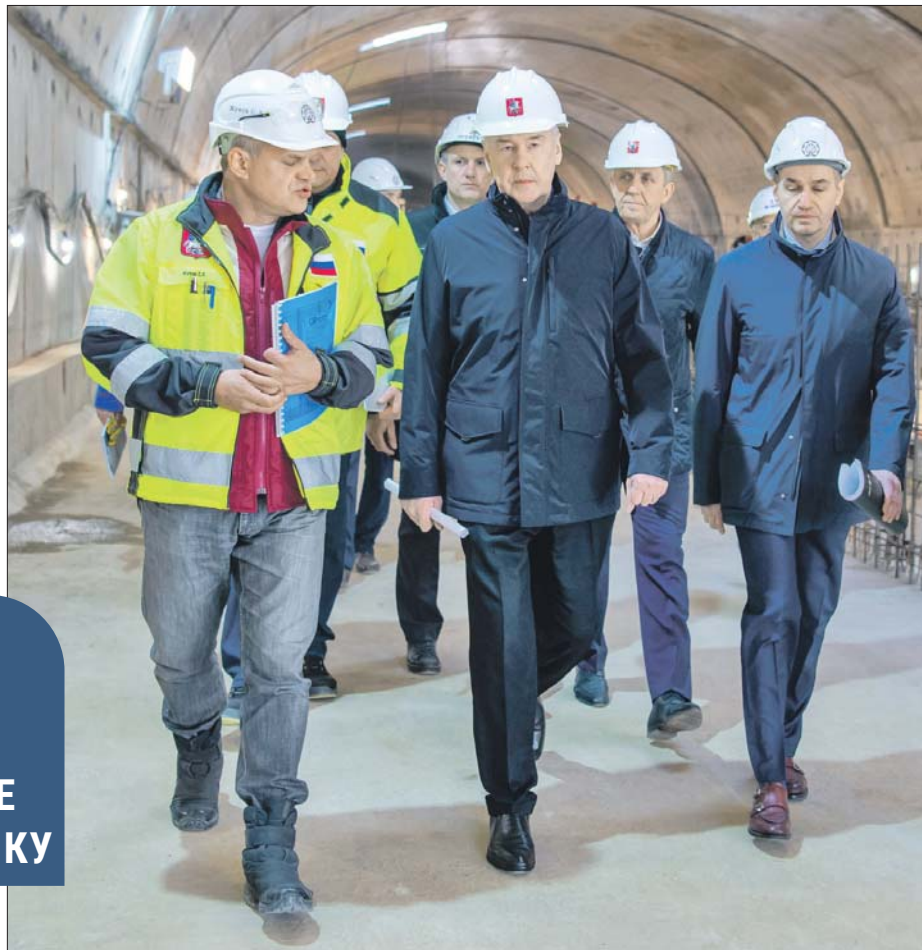
Сергей Собянин проверил, как идут работы на станции «Физтех»
