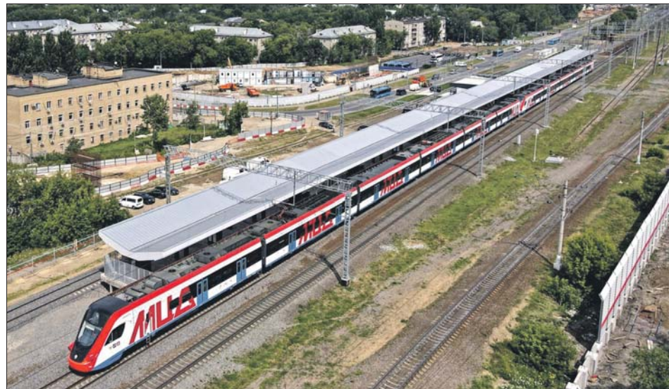
Новая станция Курьяново МЦД-2
