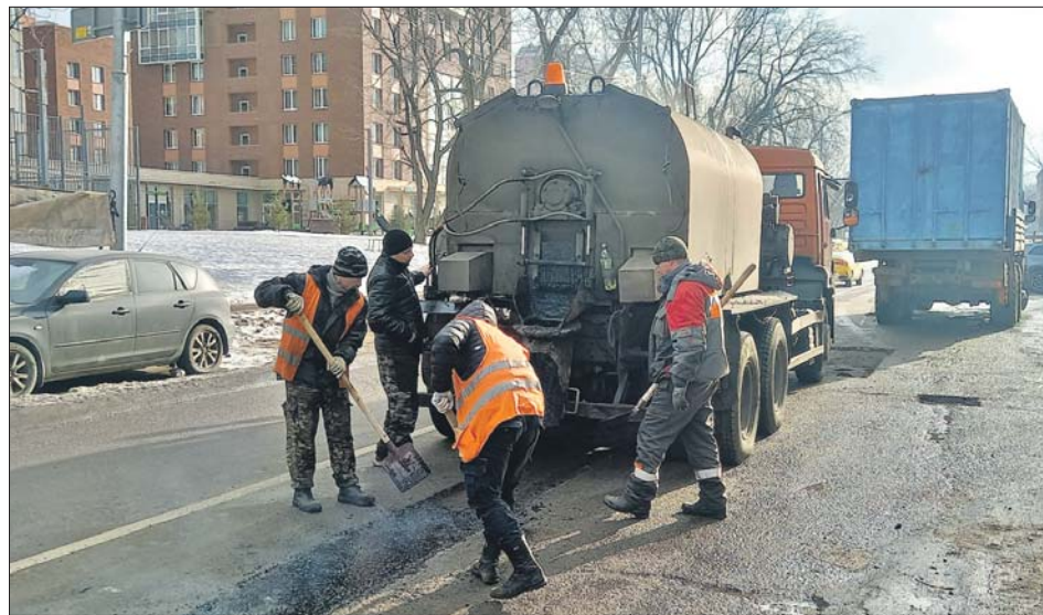
Ремонт дороги на Газгольдерной улице
