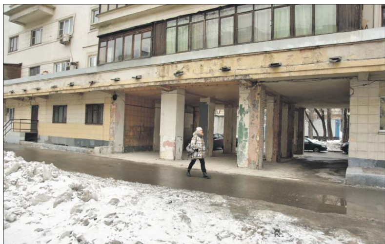
Арка дома, где была пристройка
