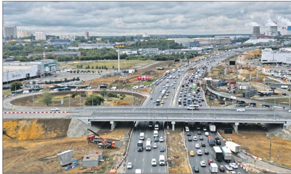
Новый путепровод на пересечении МКАД и Верхних Полей
