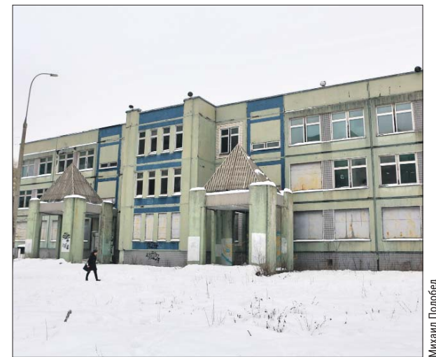
Здание будет капитально отремонтировано
