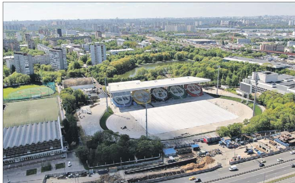
Реконструкция стадиона «Москвич» на Волгоградском проспекте. Май 2022 года
