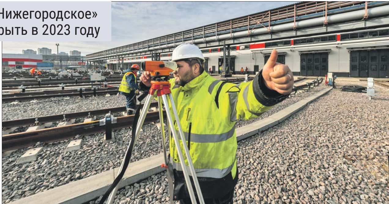
Общая длина путей депо «Нижегородское» составит более 13 километров. В год здесь смогут отремонтировать 288 вагонов
