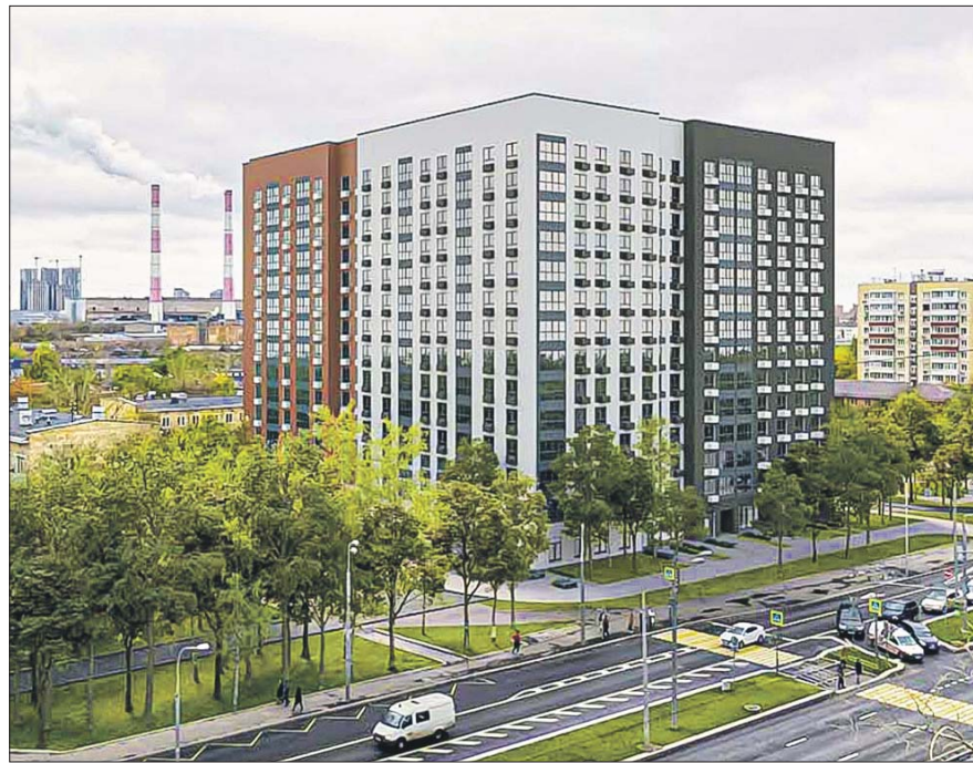
Многоэтажка возведена по монолитной технологии и состоит из трёх секций
