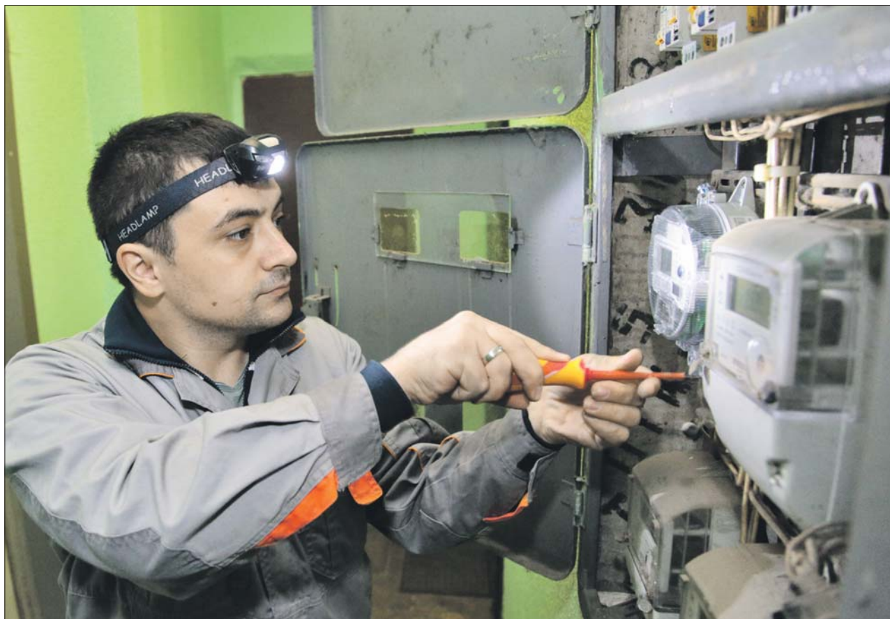
Монтер Константин Богатый устанавливает электросчётчик
