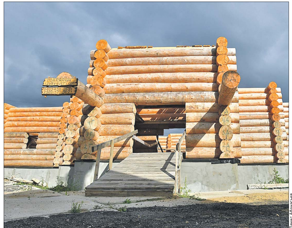
Строительство на Тихорецком бульваре
