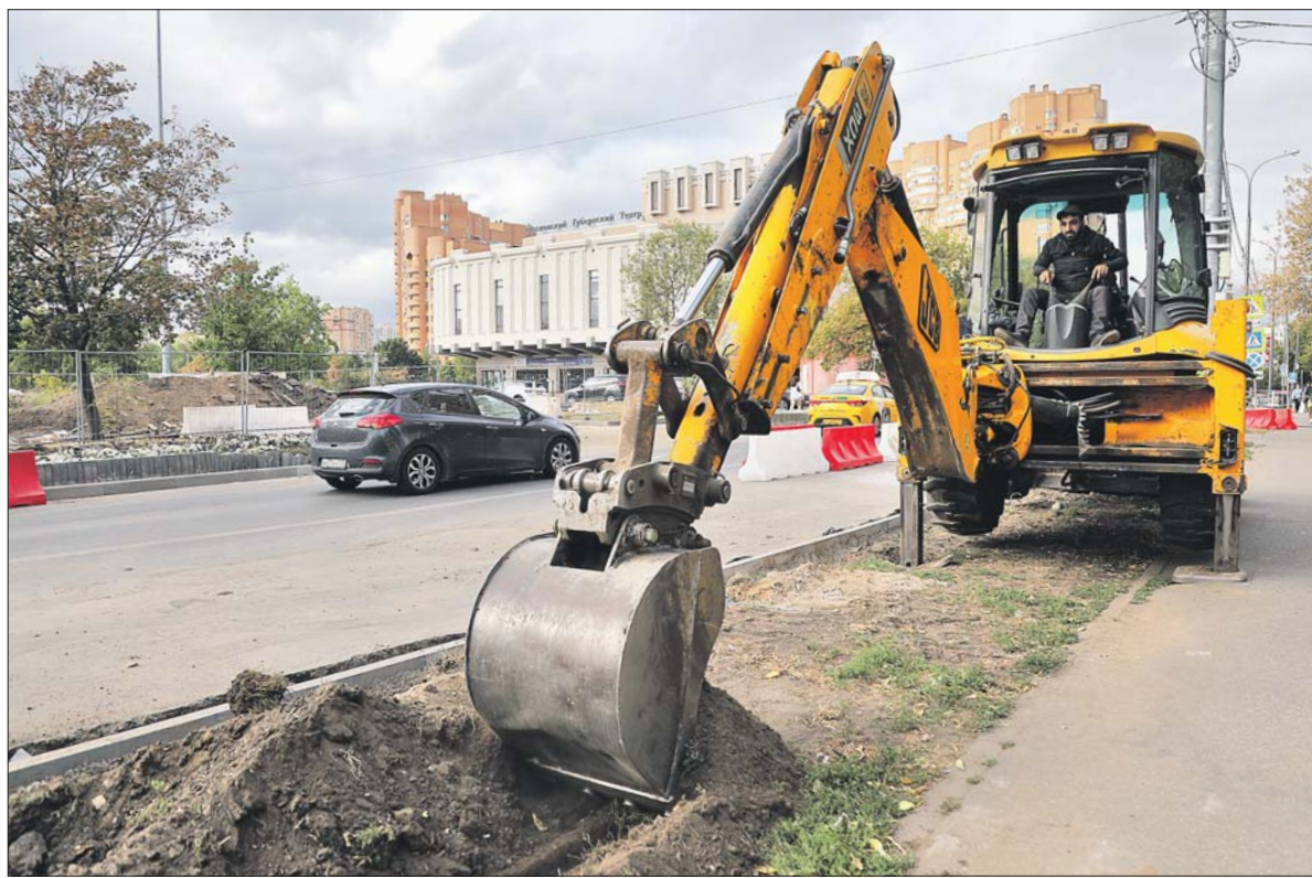
Работы на Зеленодольской улице. Слежавшийся грунт с газонов вывезут, а на его место положат новый, который весной засеют травой
