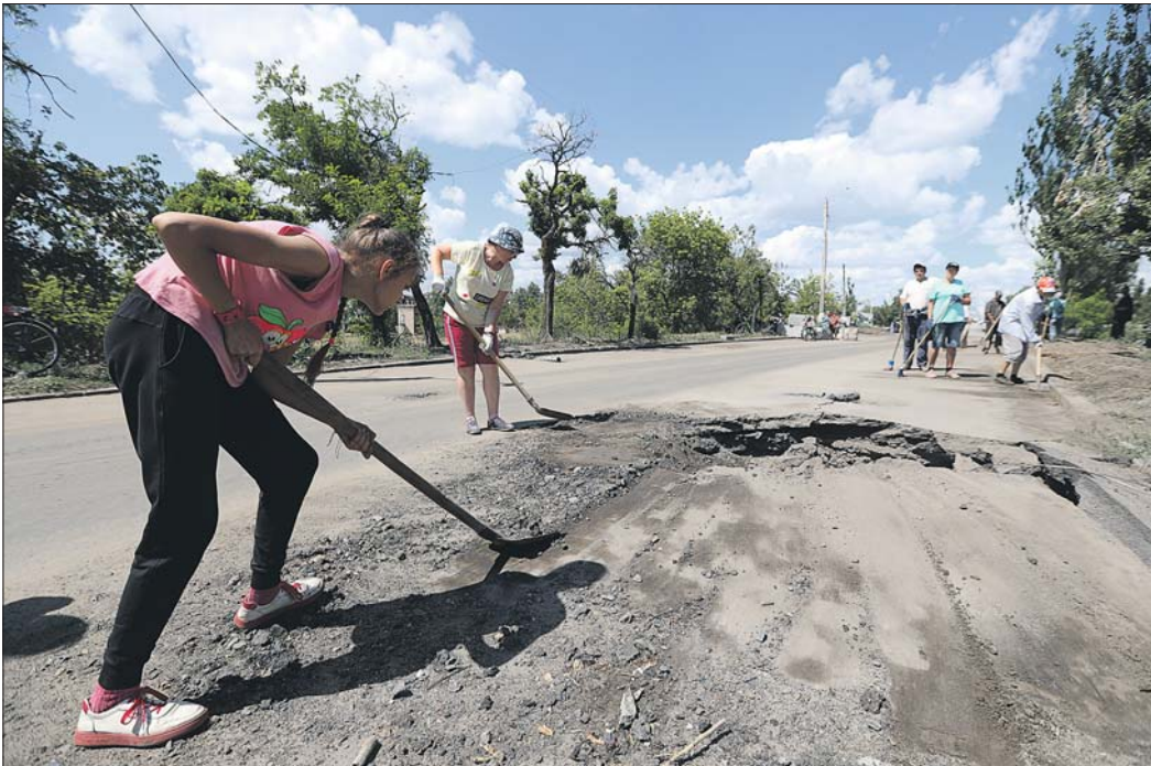
Городские власти Рубежного создали из местных жителей временные бригады, которые засыпают воронки от снарядов
