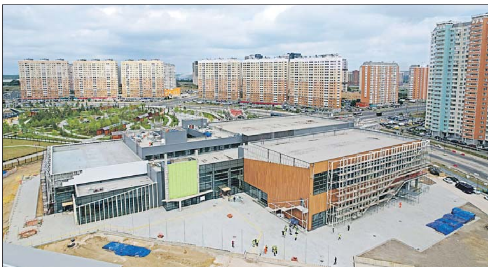
Строители физкультурно-оздоровительного центра завершили монтаж фасада
