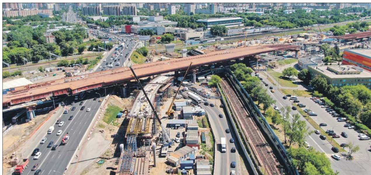
Строительство развязки около пересечения Волгоградского проспекта и Люблинской улицы
