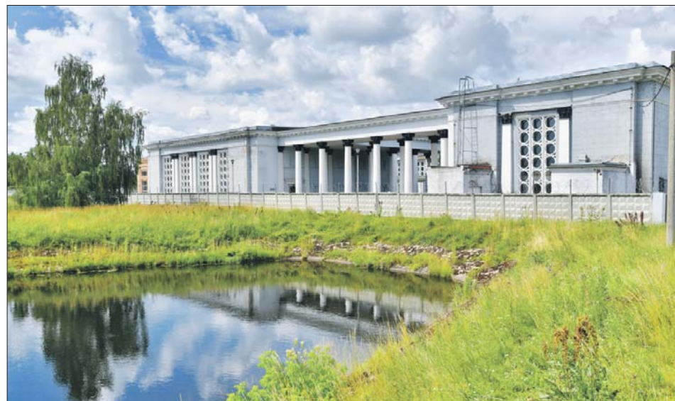
Насосный цех, а рядом с ним пруд, в котором поначалу отстаивается волжская вода
