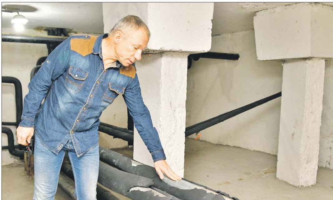
Руководитель рабочей группы по контролю за капремонтом в ЮВАО Андрей Молотков осматривает подвал дома 6 на Шоссейной улице
