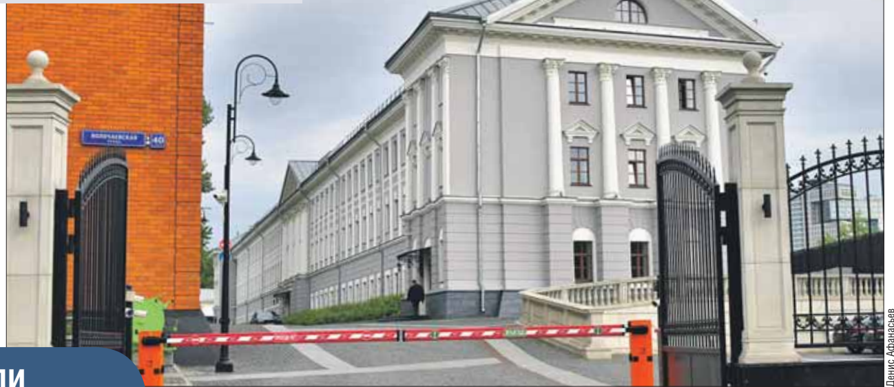
Здание ткацкого корпуса золотоканительной фабрики Алексеевых отреставрировано (Волочаевская ул., 40г, стр. 4)
