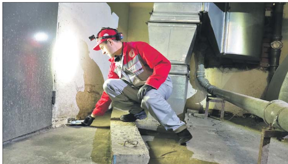
Дератизация в подвале жилого дома
