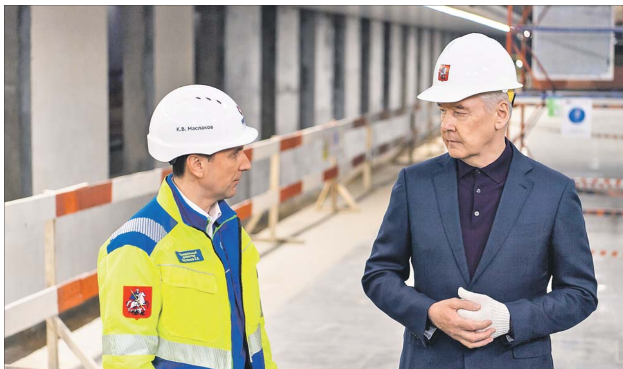
Сергей Собянин на строящейся станции БКЛ «Текстильщики»
