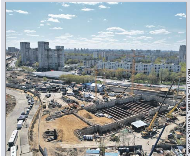
Строительство станции БКЛ «Печатники»
