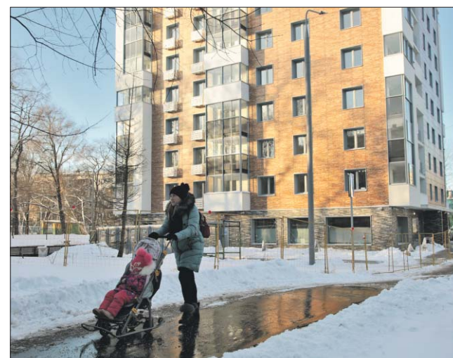
Новостройку на улице Шумилова, 4, сдали в эксплуатацию
