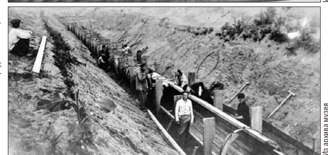
Строительство Люберецких полей фильтрации
