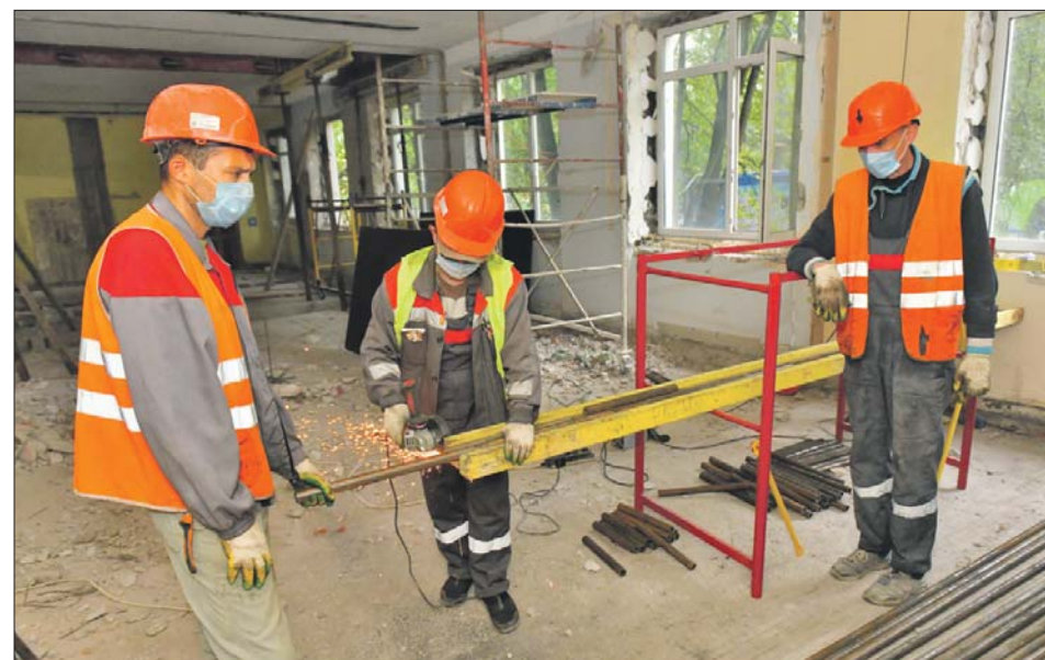
Сейчас рабочие укрепляют потолки здания
