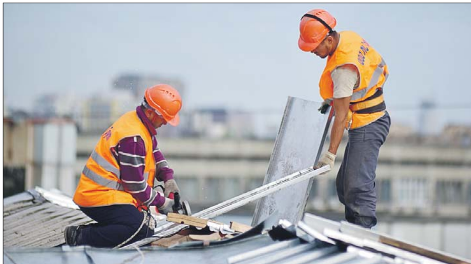
Бывает, что обновление кровли, системы отопления и других элементов планируют проводить в разное время. По желанию жильцов работы можно объединить
