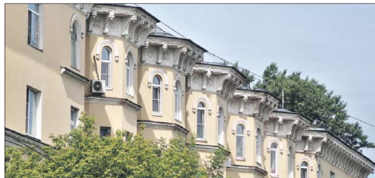
Эркеры жилого дома на Южнопортовой улице
