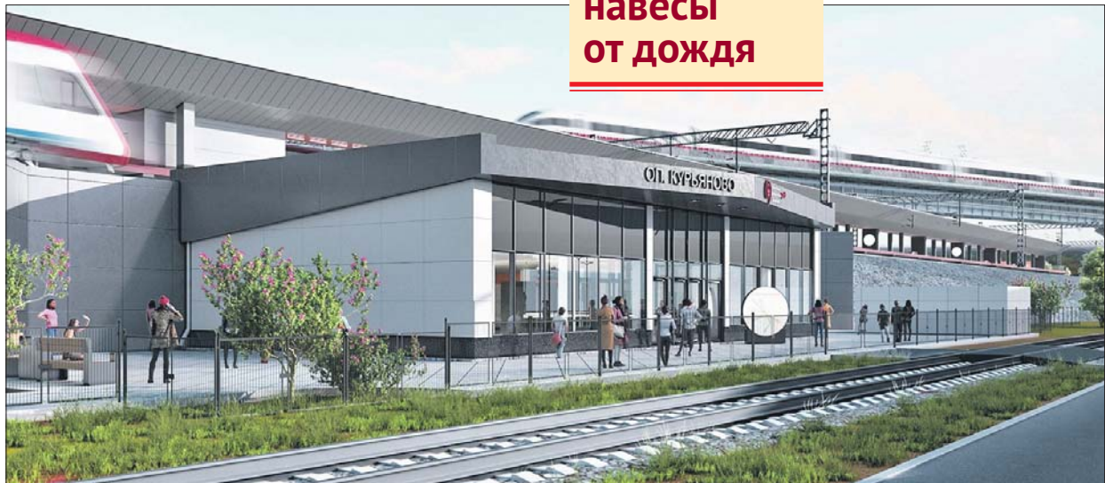
Здесь будут останавливаться поезда наземного метро МЦД-2 Нахабино — Подольск
