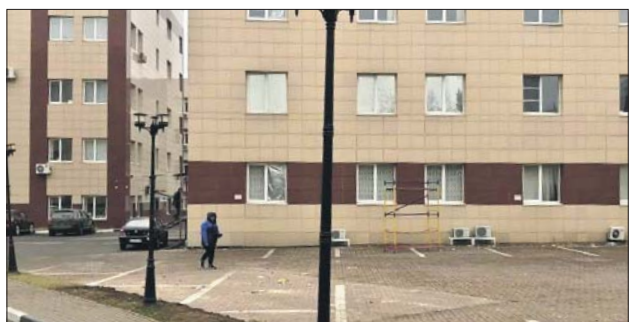
Конструкции демонтировали, участок освободили
