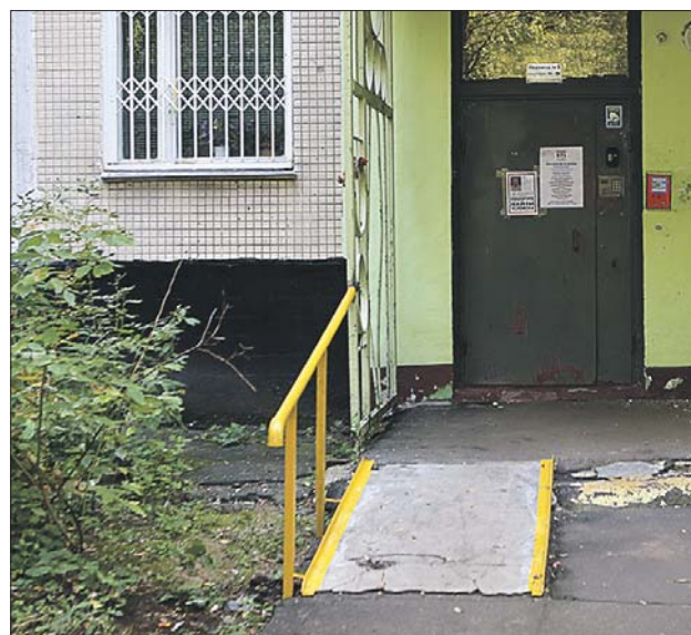
Вход в 5-й подъезд
