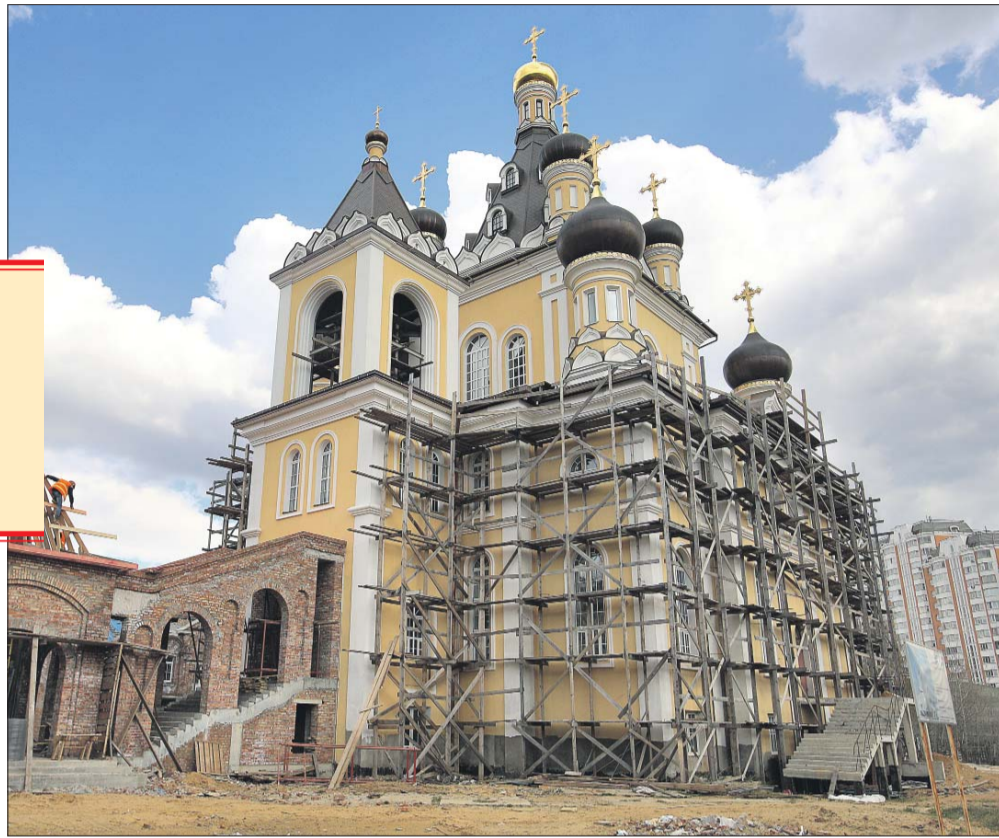
Завершить отделочные работы постараются к февралю будущего года
