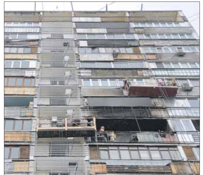
Фасадные работы в доме 6 на 2-й Кабельной
