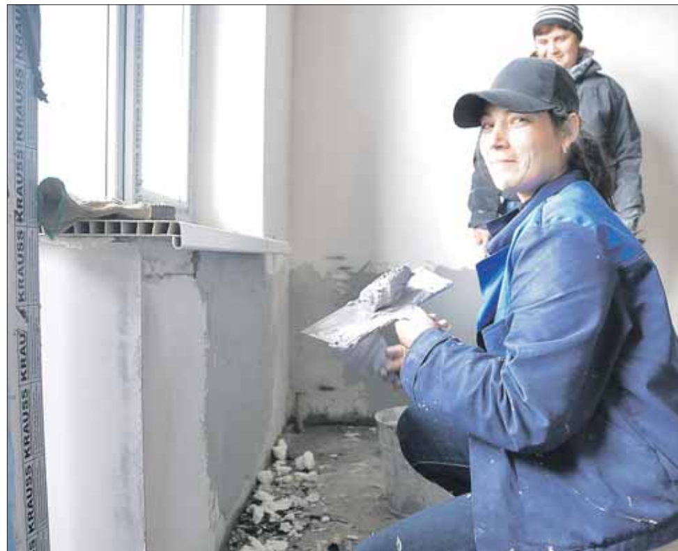
Ремонтники работают на объекте в две смены
