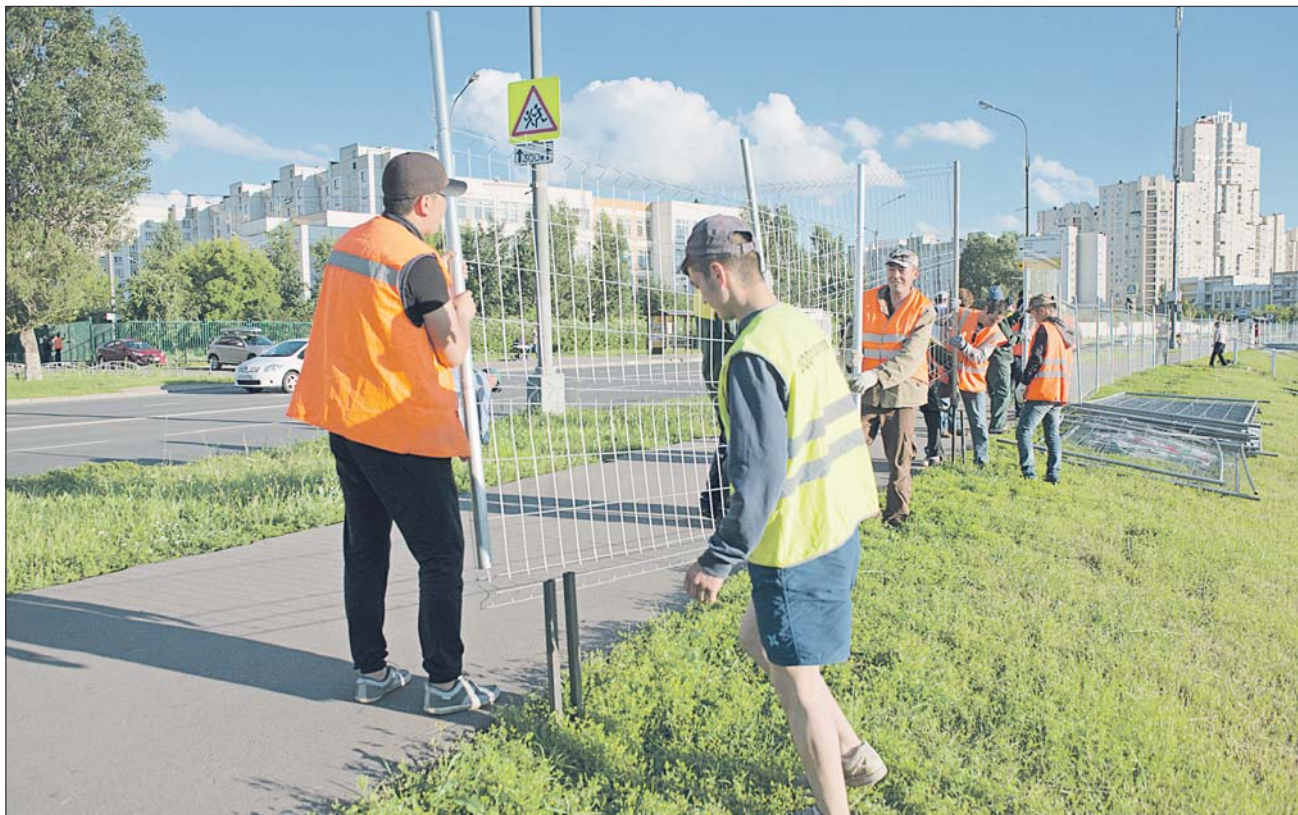
Строители убирают забор
