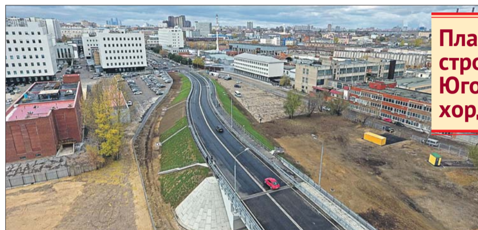
Путепровод на Южнопортовой улице, открытый осенью 2017 года
