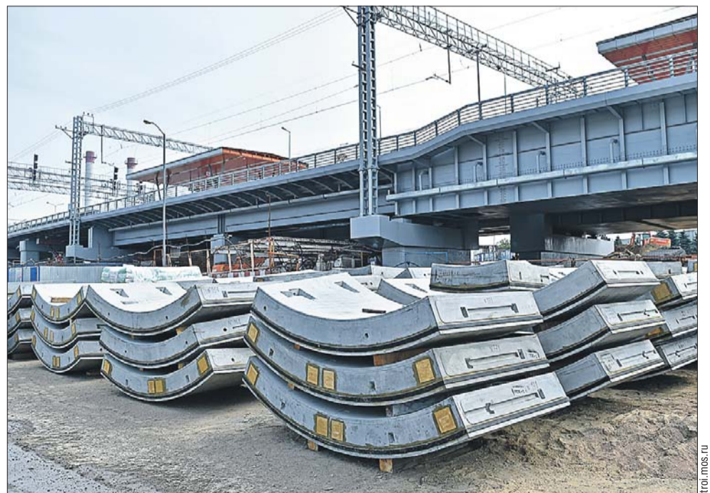
Строительство станции метро «Нижегородская»
