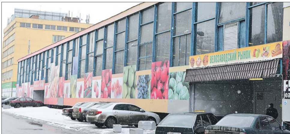
Сейчас в здании рынка идёт капремонт
