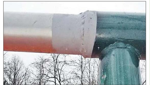
Место крепления опорной трубы и стойки качелей заварили
