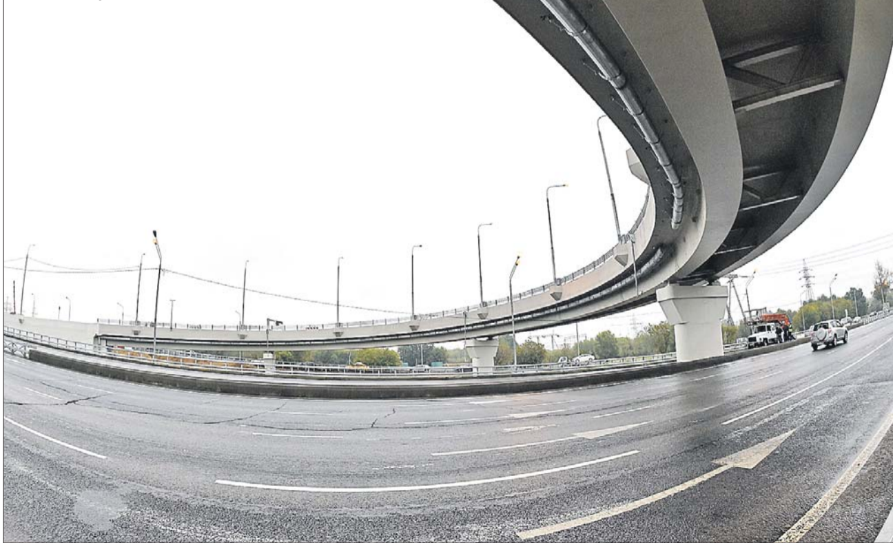
Развязка на пересечении Рязанского проспекта и МКАД
