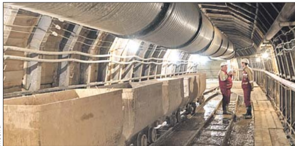
Строительные работы на станции «Окружная»
