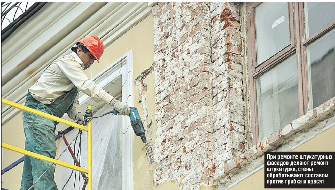
При ремонте штукатурных фасадов делают ремонт штукатурки, стены обрабатывают составом против грибка и красят
