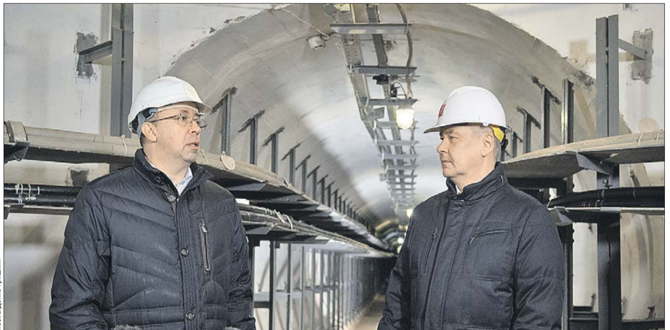
Новый коллектор для электросетей — самый длинный в Москве: почти шесть километров
