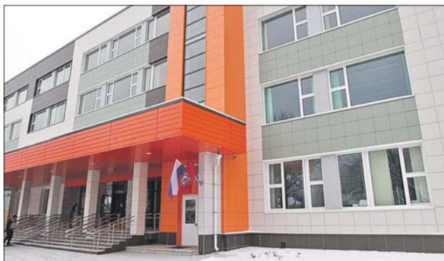
Новое здание рассчитано на 650 мест
