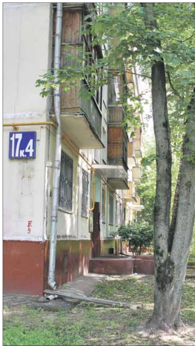
В пятиэтажке на Зеленодольской, 17, корпус 4, капремонт обойдётся более чем в 9,3 млн рублей
