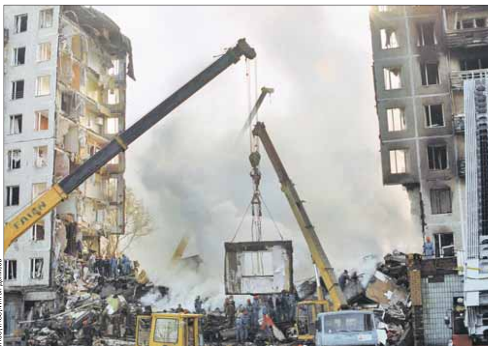
Сентябрь 1999 года. Спасательная операция завершена. Строители разбирают остатки дома 19 на улице Гурьянова
