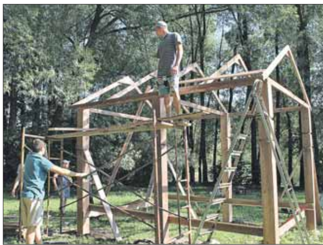
Строительство беседки в парке «Кузьминки-Люблино»
