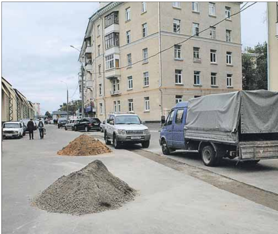
На пути к станции метро «Рязанский проспект» можно увидеть кучи земли и песка, приготовленные для засыпки ям
