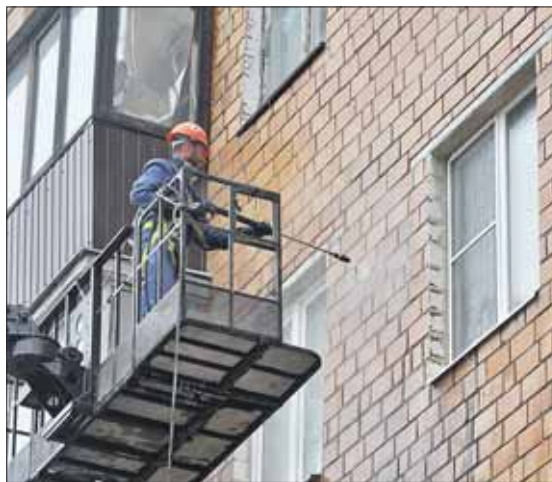
Промывка фасадов на Рязанском проспекте
