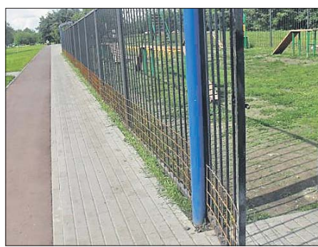
Ограду площадки на Волжском бульваре дополнили решётками
