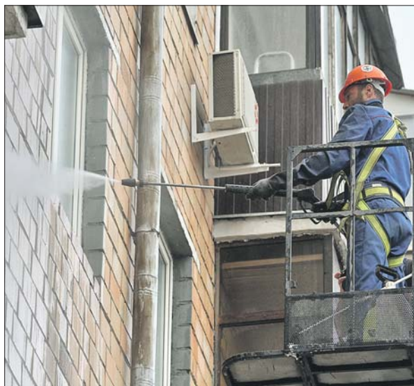
Сначала на фасад наносят специальный моющий раствор, потом его смывают под высоким давлением
