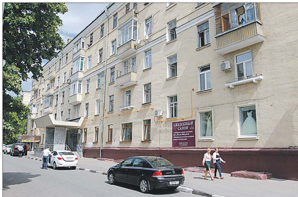
В доме 3 на 1-й Новокузьминской улице отремонтируют горячее и холодное водоснабжение
