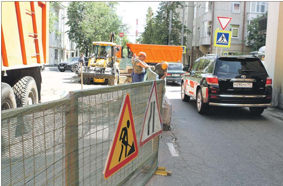
Ремонт дорог на 2-м Кабельном проезде
