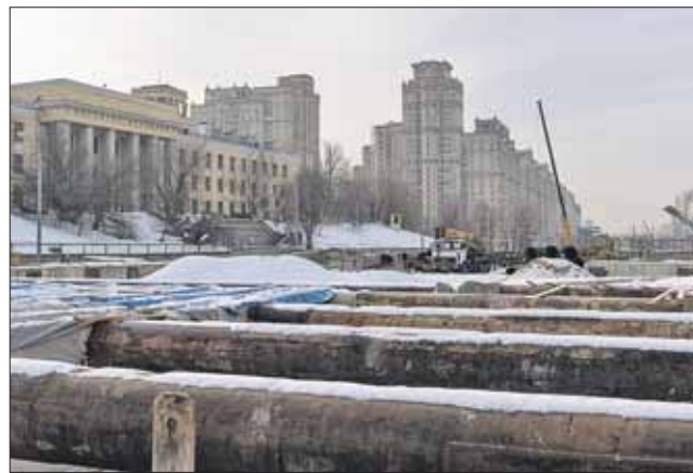
Здесь идёт строительство станции «Ломоносовский проспект»
