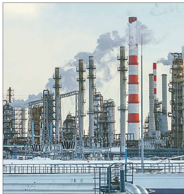
На выходе из труб установили девять газоанализаторов
