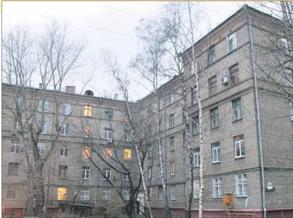
В подвале дома 7 на Новохохловской заменили трубы холодной и горячей воды и канализации
